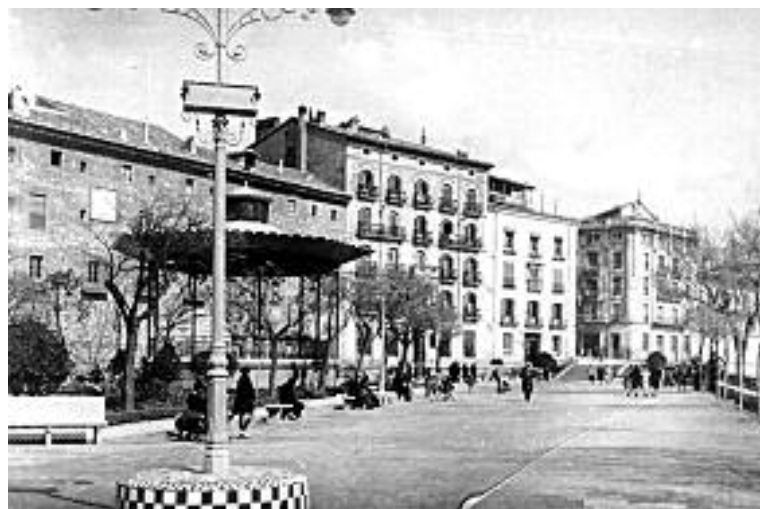
A la izquierda, convento Santo Domingo, sede del Instituto
