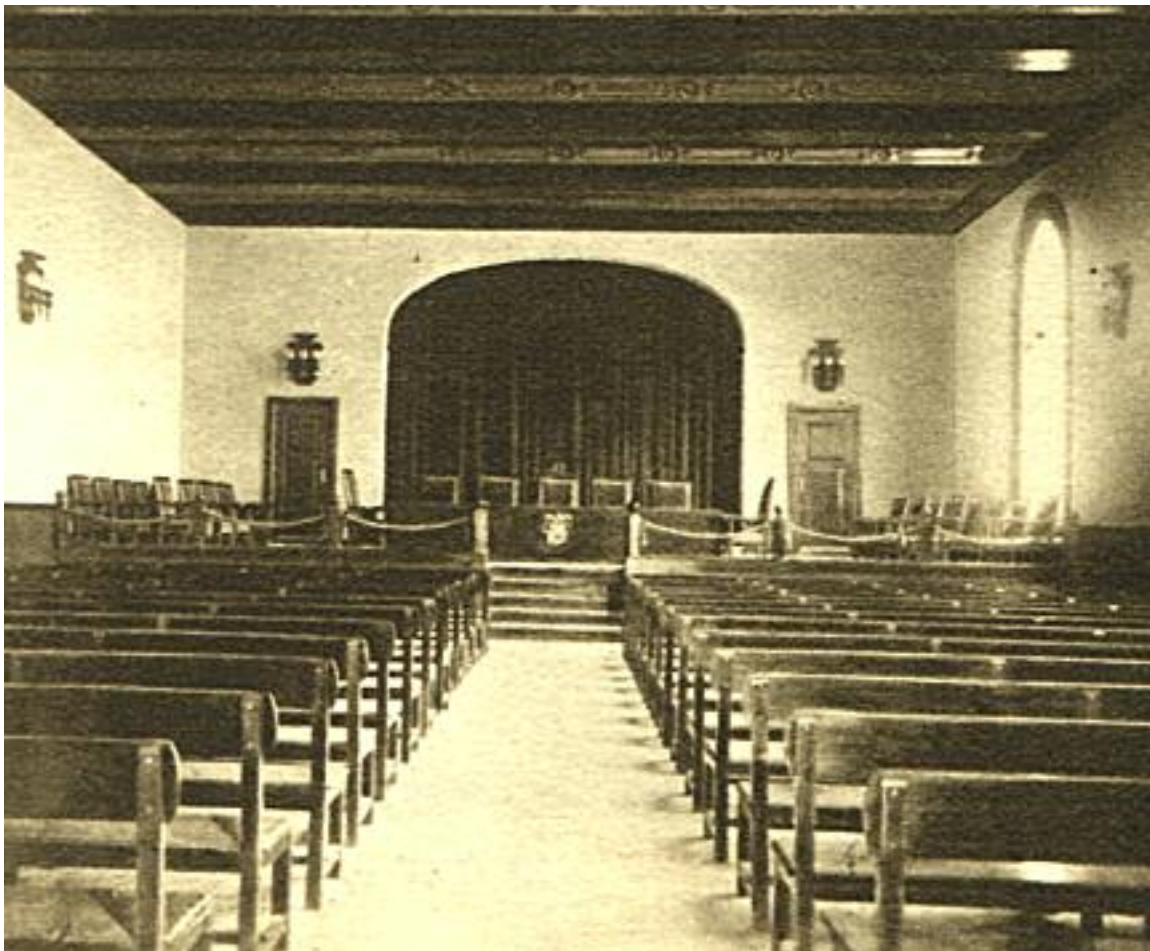
Salón de actos antes de su remodelación
